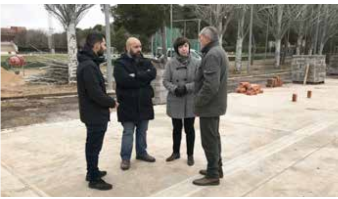
Obras de la nueva pista de hockey sobre patines
