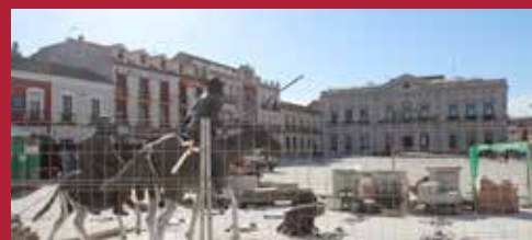
Alcázar, en obras Ciudad Renovada
