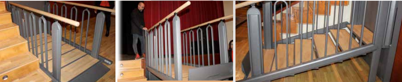
Escalera/plataforma accesible para acceder del patio de butacas al escenario
